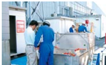
PCBの搬出作業
